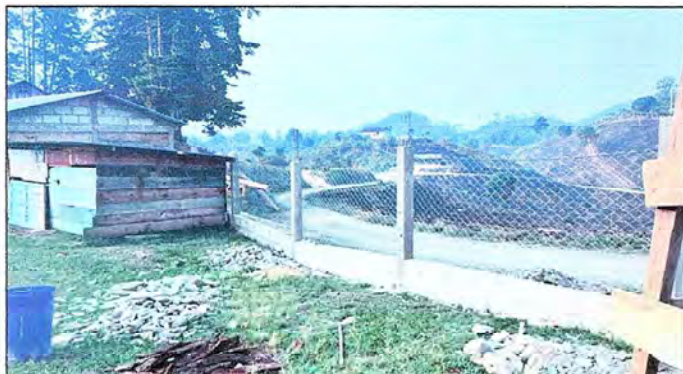
Foto 3: colocacion de concretos para la circulacion
