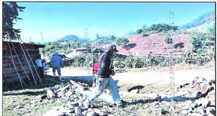
Foto 2: Colocacion de hierro para los parales de concreto
