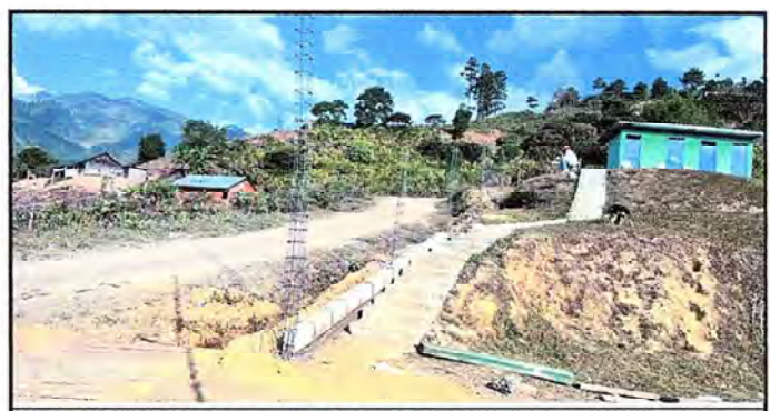
Foto 6: Se observa el espacio para el porton.
