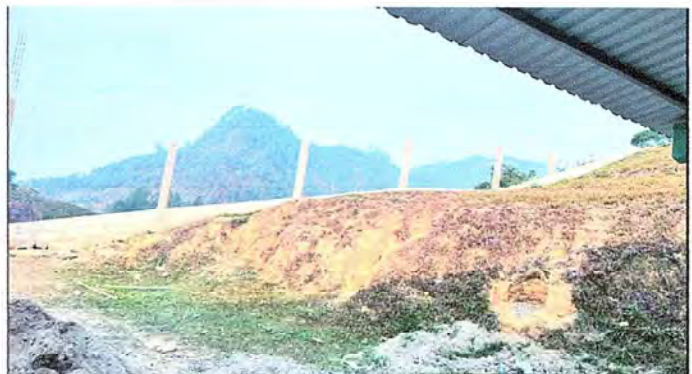
Foto 4: colocacion de malla
